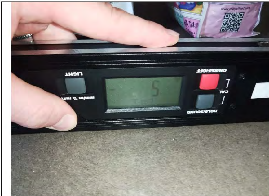
Фото №37. Измерение уровня пола в кухне.
