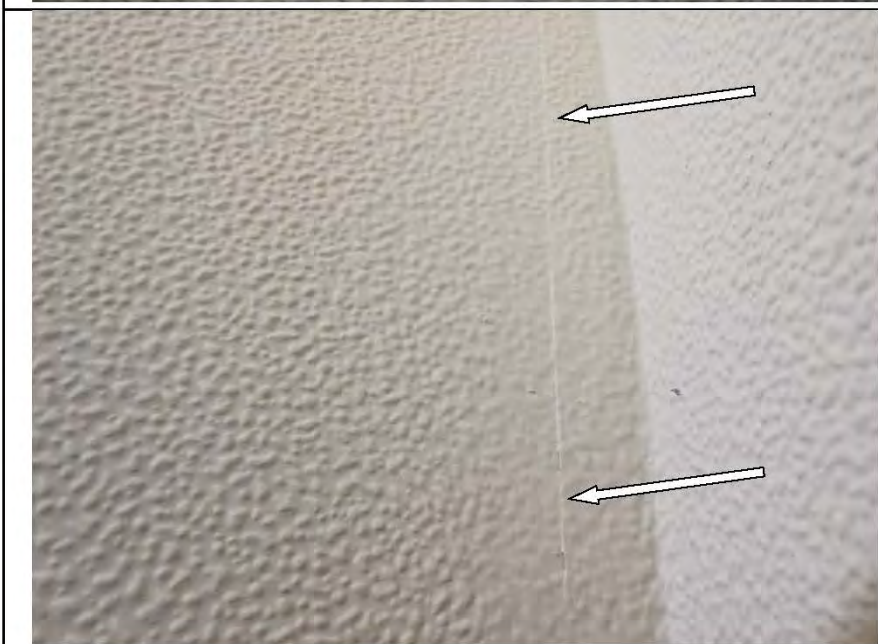
Фото №18. Читаемые обойные стыки в гардеробной.
