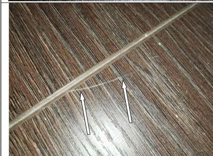
Фото №30. Царапины на напольном покрытии из ламината в спальне.
