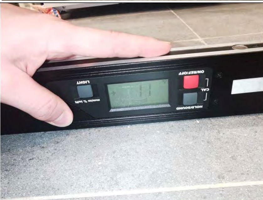
Фото №35. Измерение уровня пола в ванной комнате.
