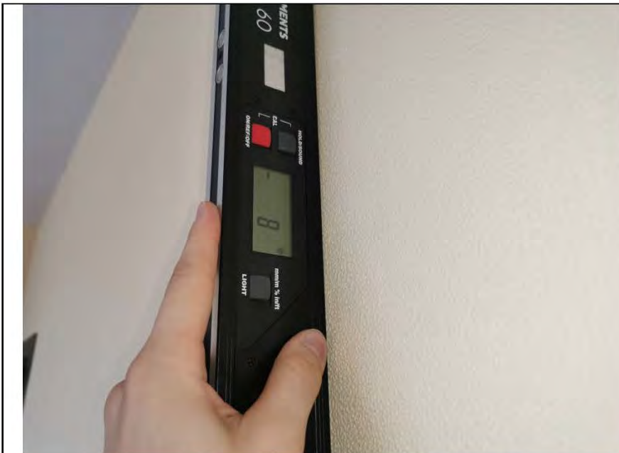
Фото №13. Измерение уровня стен в гостиной.
