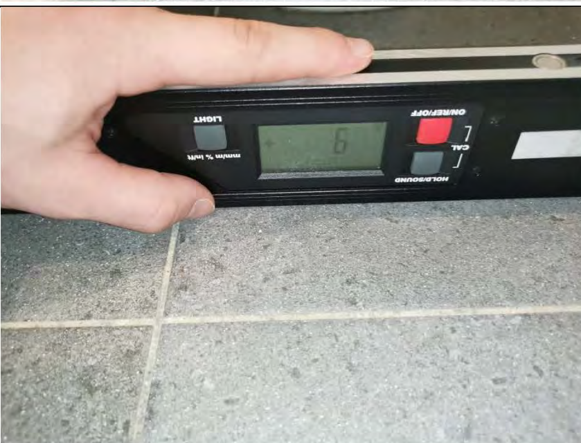
Фото №36. Измерение уровня пола в санузле.
