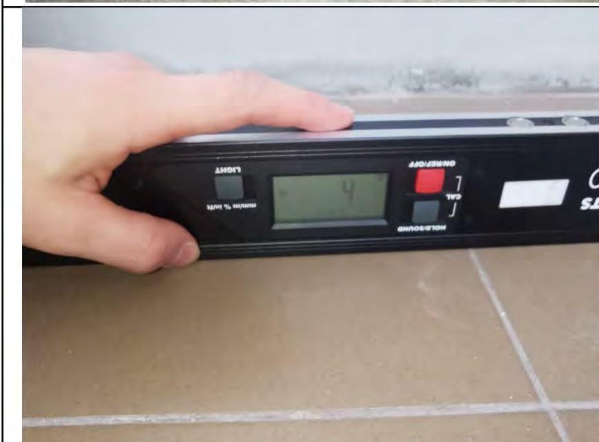
Фото №38. Измерение уровня пола на лоджии.
