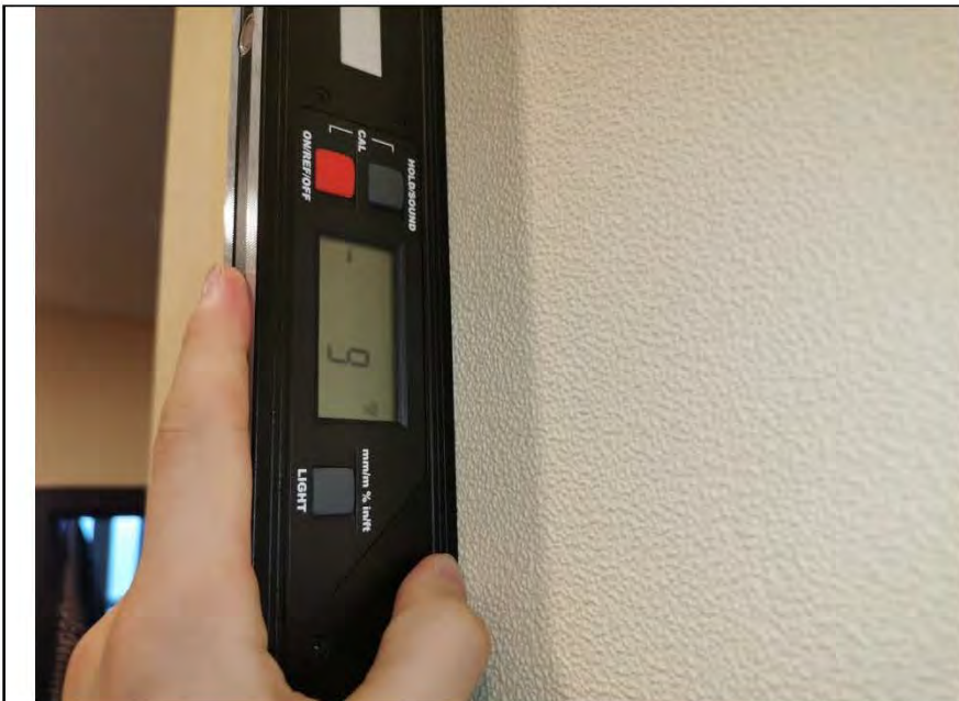
Фото №10. Измерение уровня стен в коридоре.
