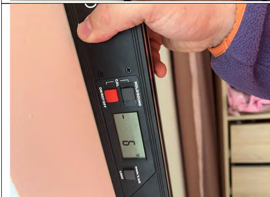
Фото №17. Измерение уровня стен в спальне.
