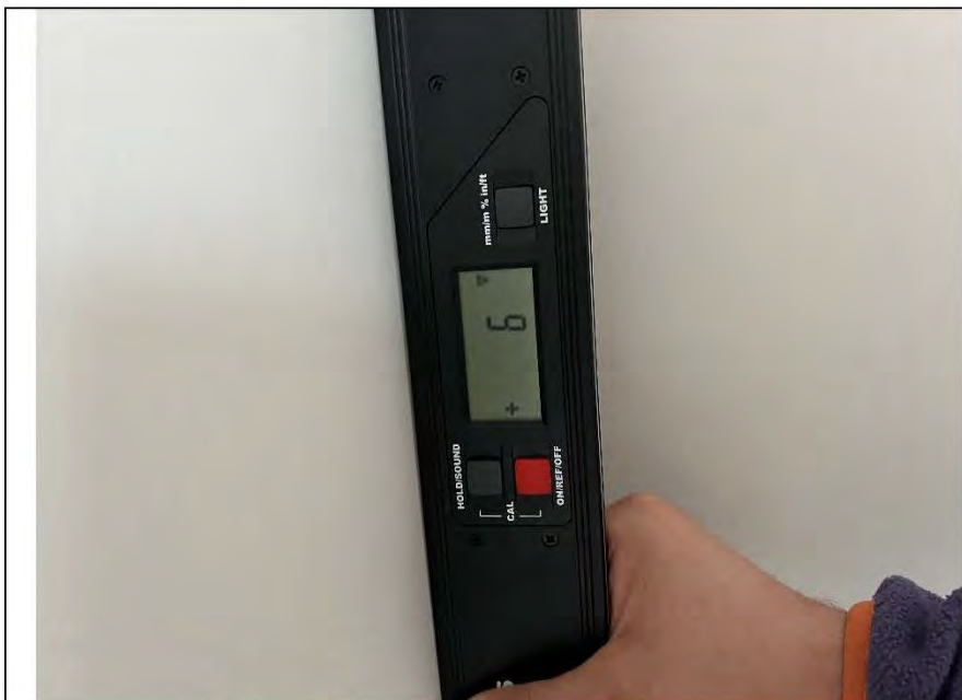
Фото №16. Измерение уровня стен в гостиной.
