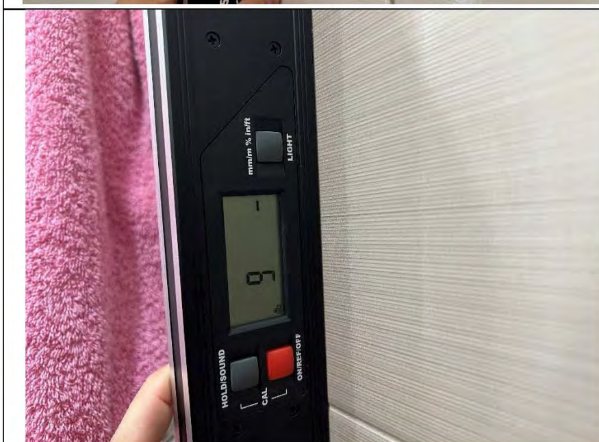
Фото №9. Измерение уровня стен в ванной комнате.
