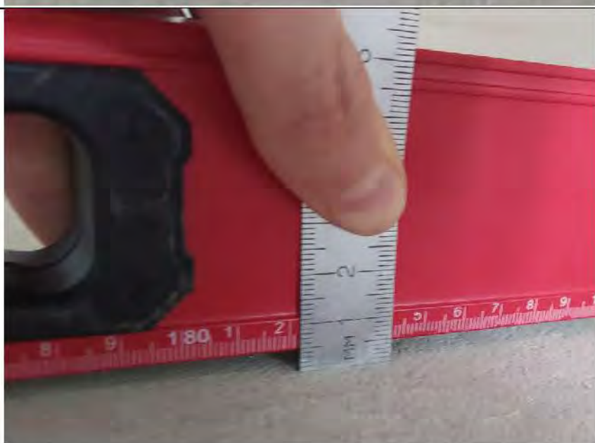
Фото №12. Измерение уровня стяжки пола в кухне.
