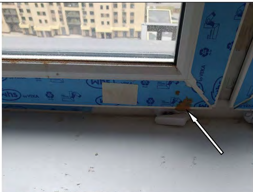
Фото №40. Дефект профиля ПВХ оконного блока в гостиной (загрязнение монтажной пенной).
