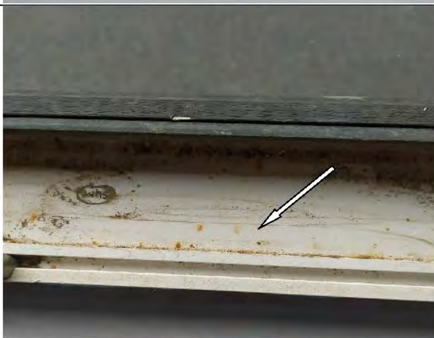
Фото №38. Окалины на профиле ПВХ оконного блока в спальне.
