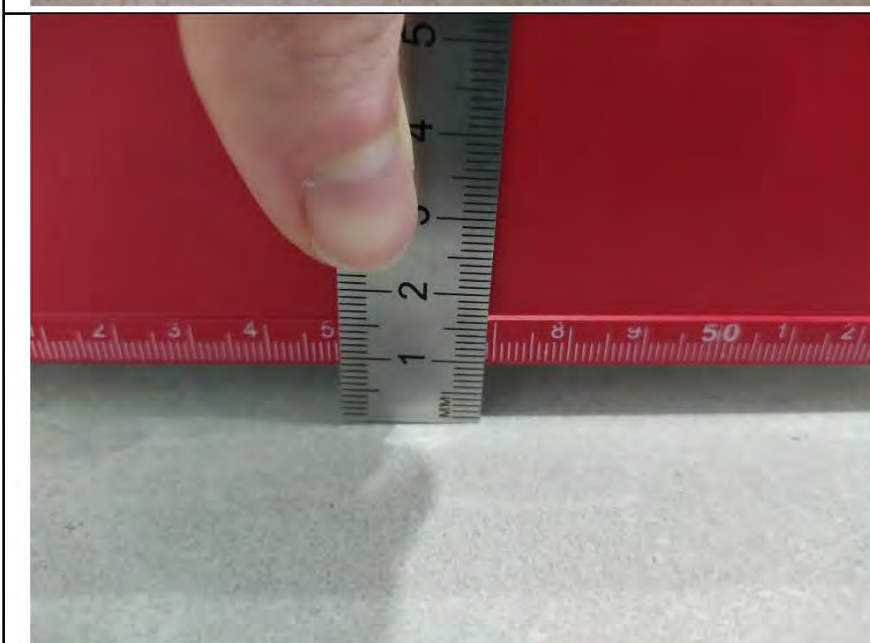
Фото №21. Измерения уровня напольного покрытия в прихожей (керамическая плитка).
