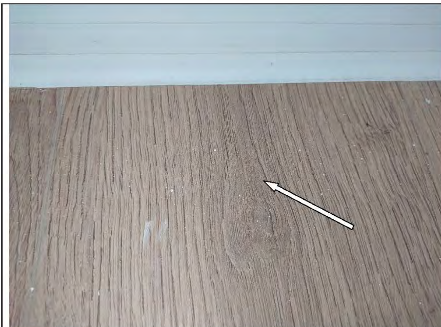
Фото №67. Загрязнение малярными составами досок ламината в гостиной.
