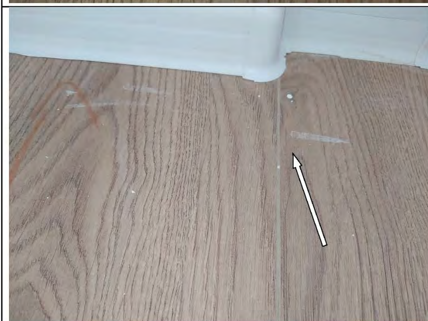
Фото №66. Загрязнение малярными составами досок ламината в кухне.
