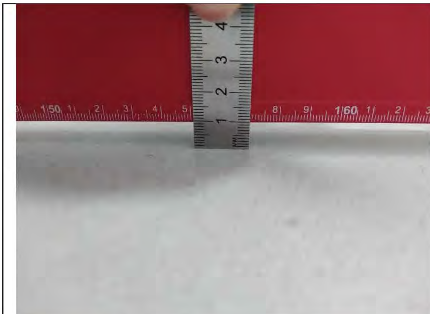
Фото №22. Измерения уровня напольного покрытия в санузле (керамическая плитка).
