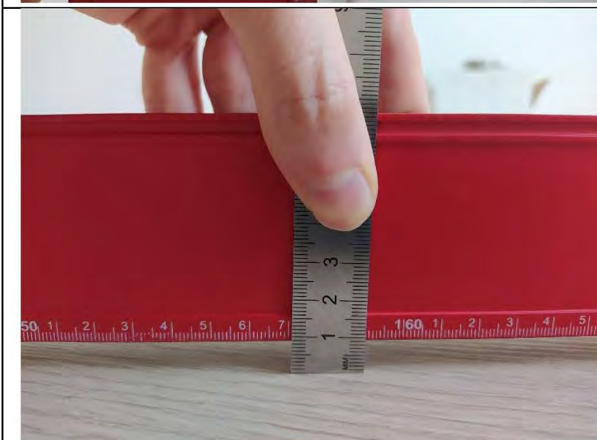
Фото №15. Измерения уровня напольного покрытия в гостиной.
