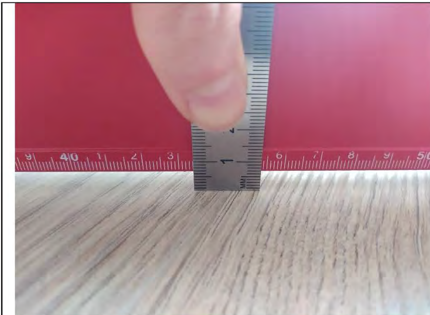
Фото №16. Измерения уровня напольного покрытия в спальне.
