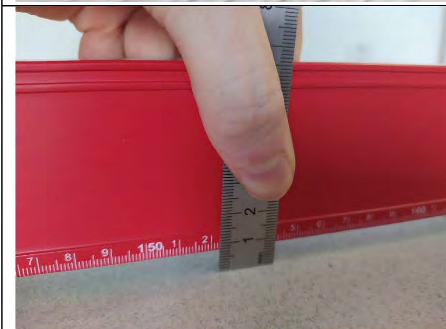
Фото №20. Измерения уровня напольного покрытия в кухне (керамическая плитка).
