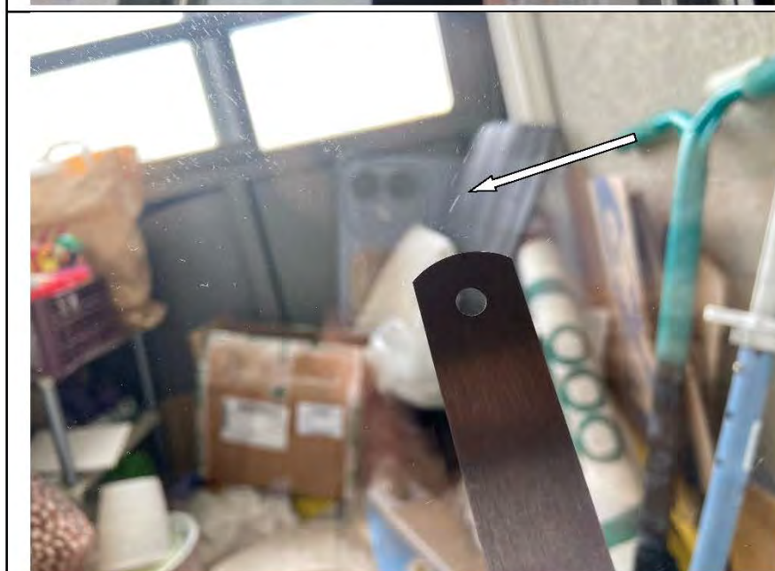
Фото №32. Царапина на стеклопакете оконного блока ПВХ в кухне.
