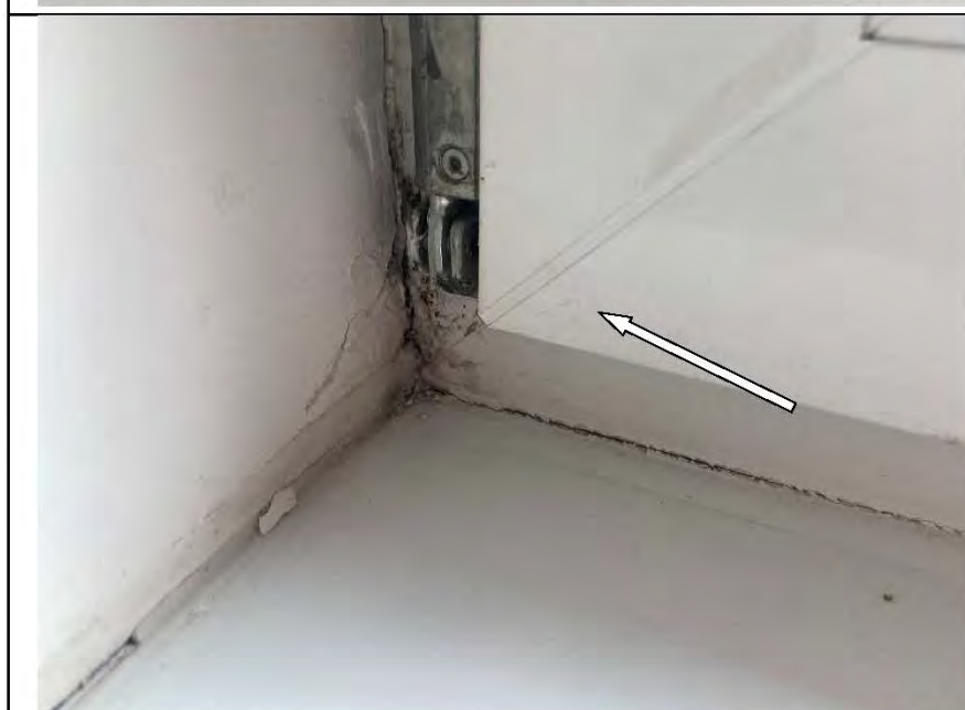
Фото №29. Дефект на профиле оконного блока ПВХ в детской.
