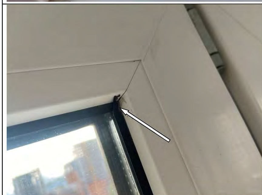
Фото №59. Дефект на уплотнительной ленте оконного блока ПВХ в детской.
