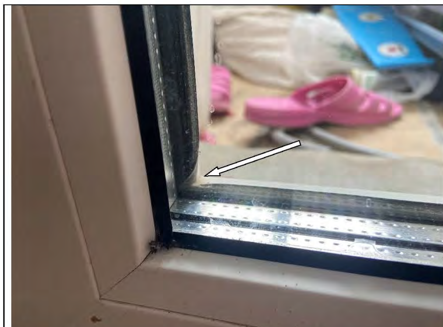
Фото №52. Дефект на уплотнительной ленте оконного блока ПВХ в кухне.
