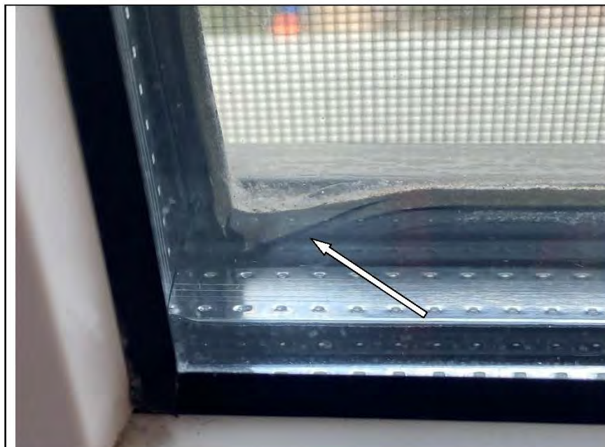
Фото №58. Дефект на уплотнительной ленте оконного блока ПВХ в спальне.
