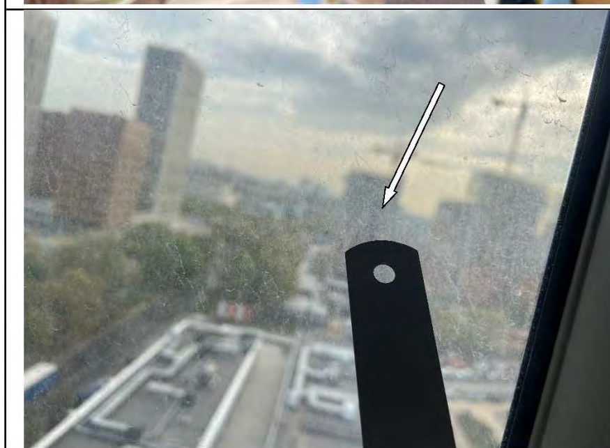
Фото №33. Царапина на стеклопакете оконного блока ПВХ на лоджии.
