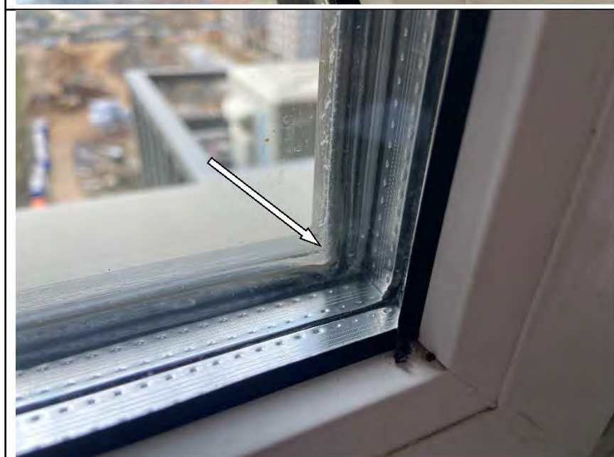
Фото №60. Дефект на уплотнительной ленте оконного блока ПВХ в детской.
