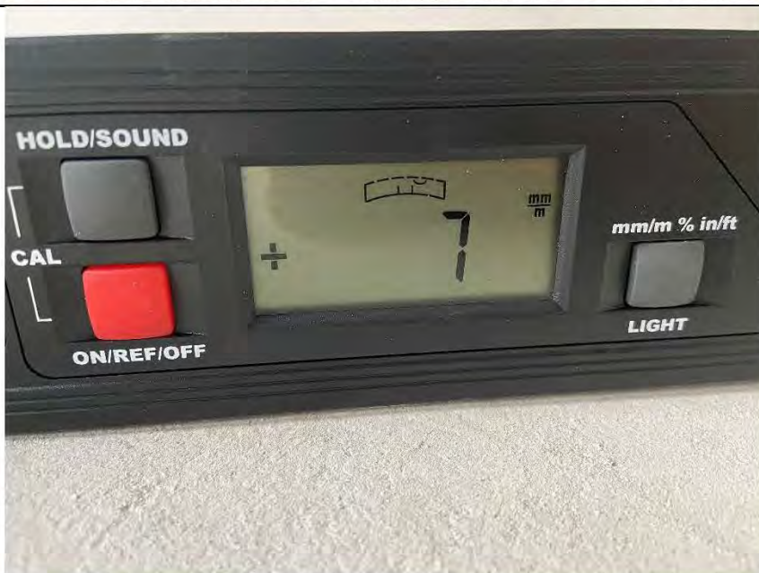
Фото №75. Отклонения поверхности напольного покрытия от плоскости в квартире.
