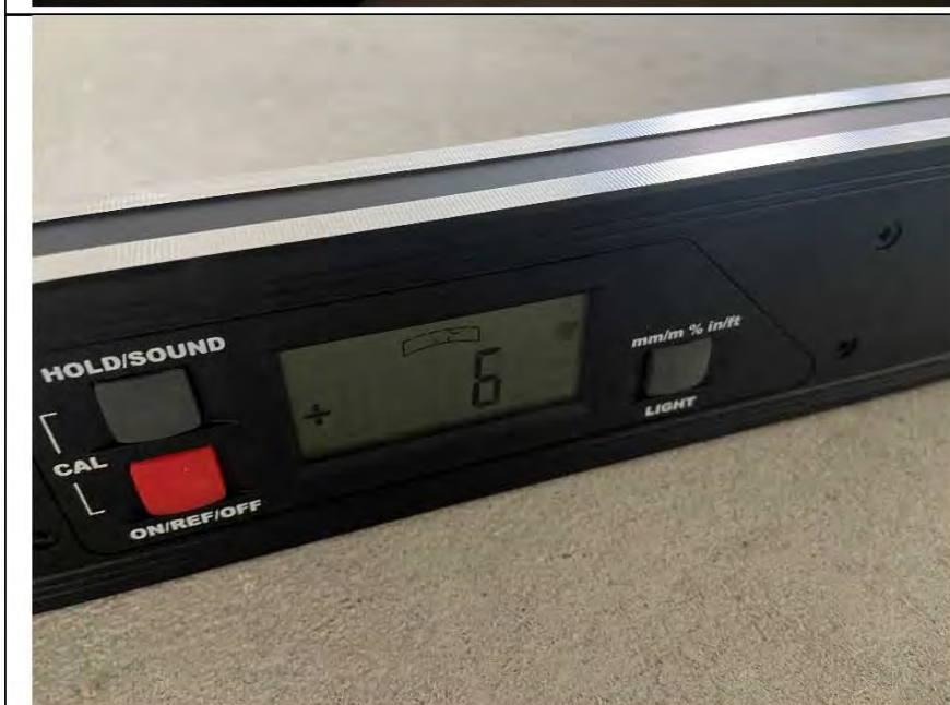
Фото №72. Отклонения поверхности напольного покрытия от плоскости в квартире.
