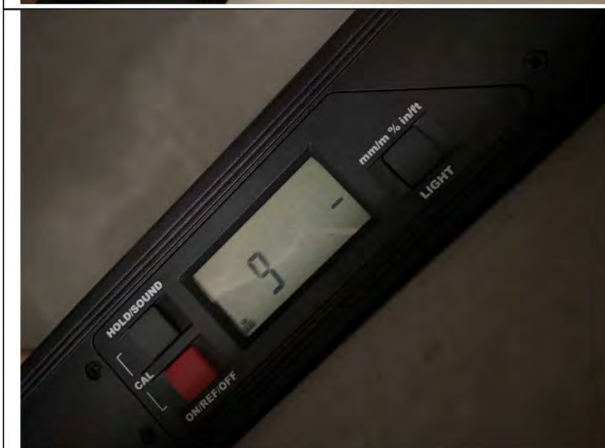
Фото №71. Измерение стен по уровню вертикальности в квартире.
