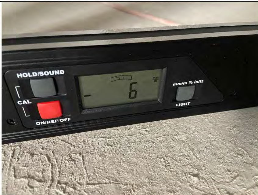
Фото №74. Отклонения поверхности напольного покрытия от плоскости в квартире.
