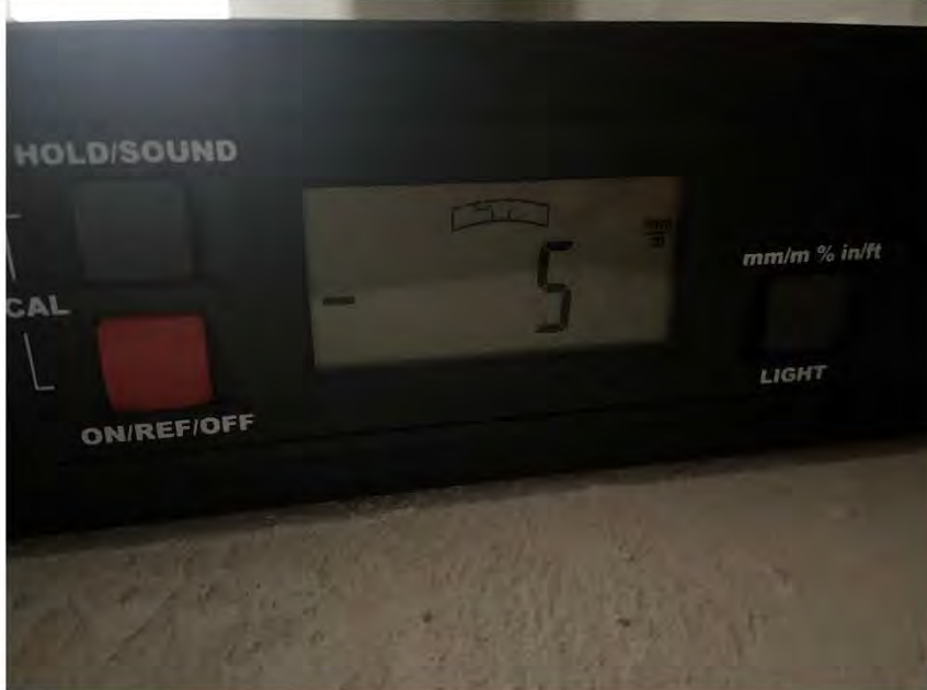
Фото №78. Отклонения поверхности напольного покрытия от плоскости в квартире.
