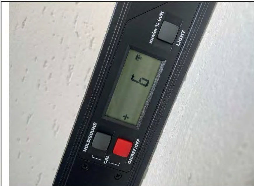
Фото №7. Измерение уровня стен в коридоре.
