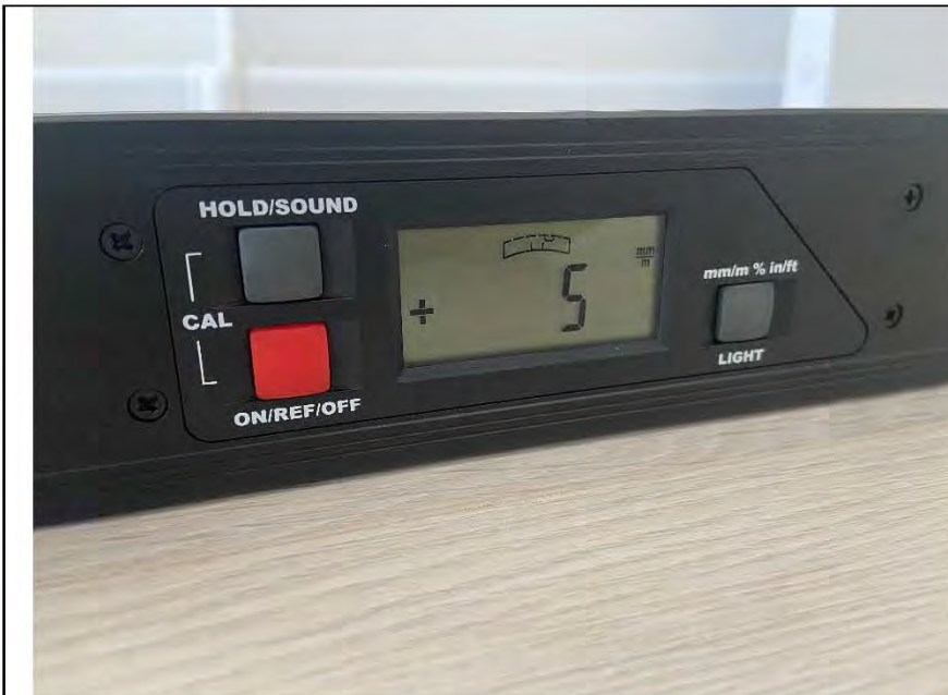
Фото №13. Отклонение напольного покрытия из ламината в спальне.
