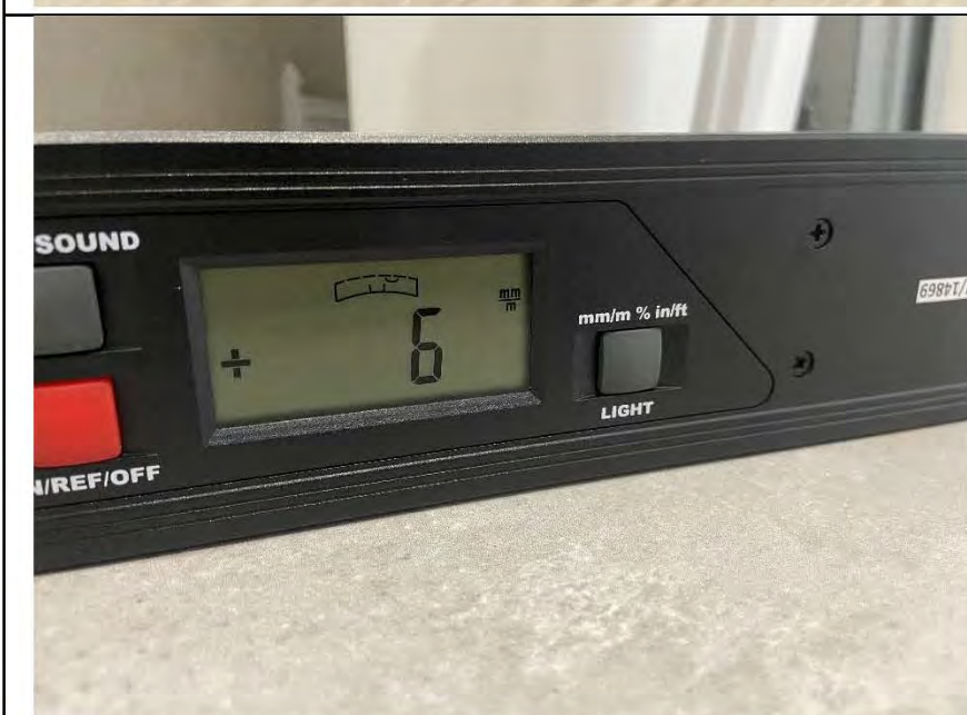
Фото №15. Отклонение напольного покрытия из ламината в ванной комнате.
