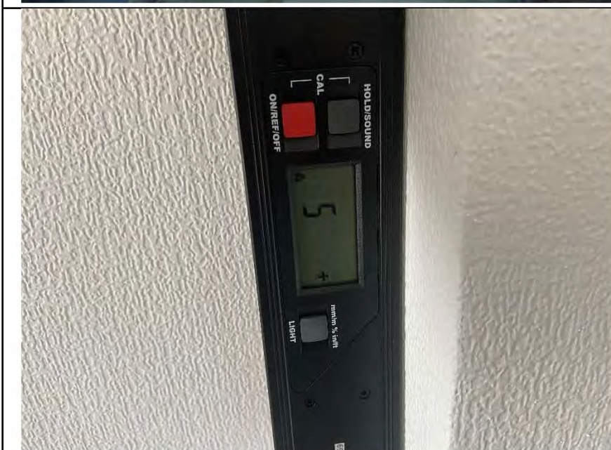
Фото №6. Измерение уровня стен в спальне.
