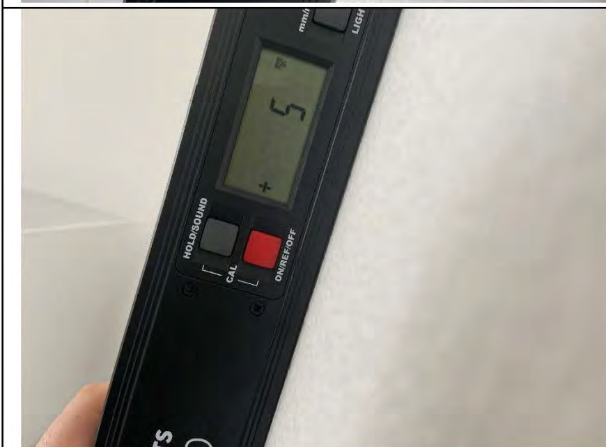
Фото №8. Измерение уровня стен в кухне.
