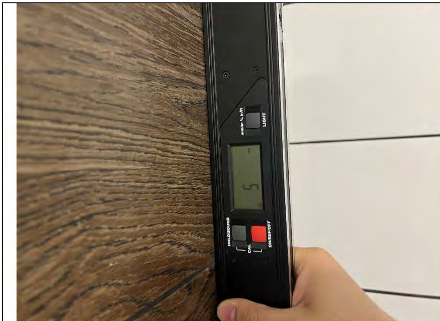
Фото №19. Измерение уровня стен в ванной комнате.
