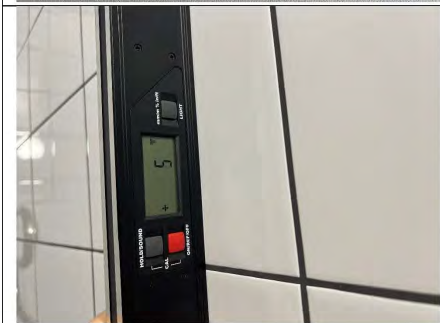
Фото №18. Измерение уровня стен в ванной комнате.
