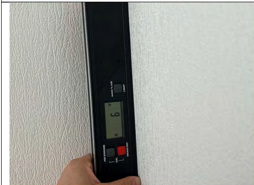
Фото №8. Измерение уровня стен в спальне.
