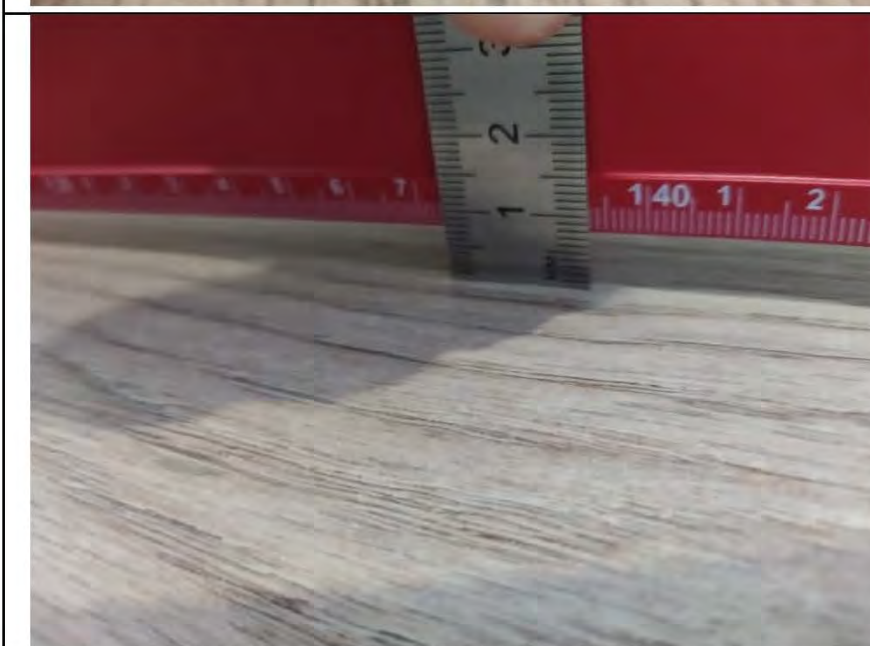
Фото №12. Измерение уровня напольного покрытия в прихожей.
