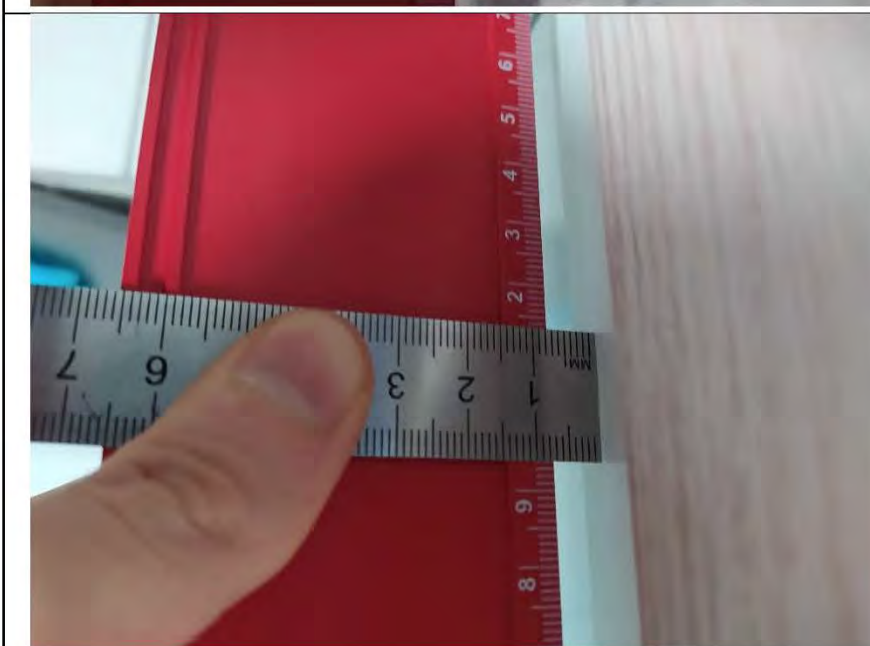
Фото №9. Измерение уровня стен в ванной комнате (керамическая плитка).
