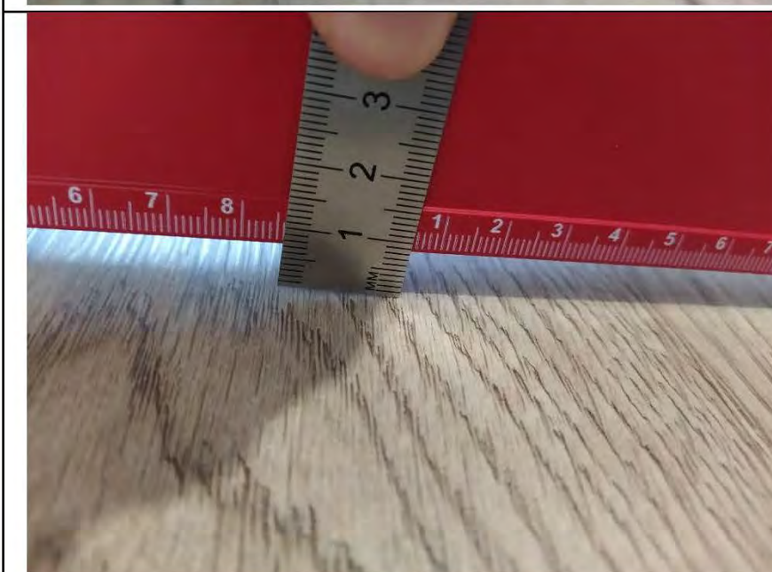
Фото №11. Измерение уровня напольного покрытия в кухне.
