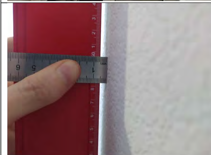
Фото №6. Измерение уровня стен в спальне.
