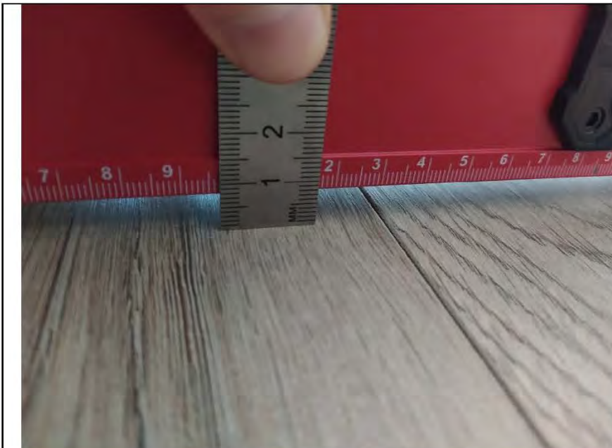
Фото №10. Измерение уровня напольного покрытия в спальне.
