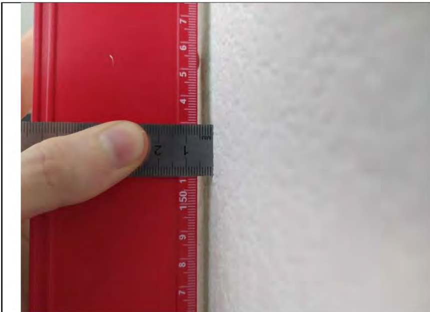
Фото №7. Измерение уровня стен в кухне.
