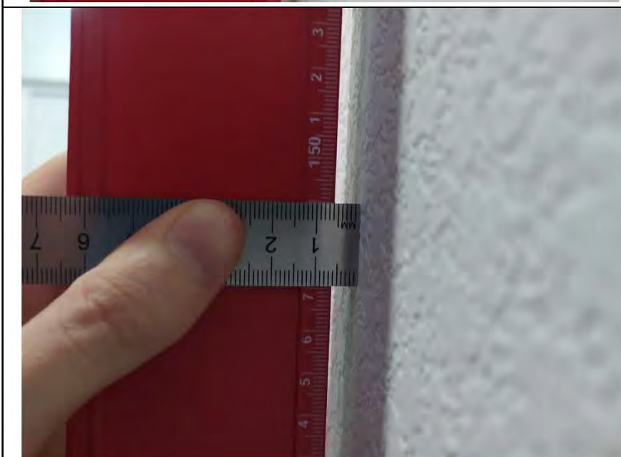
Фото №8. Измерение уровня стен в прихожей.
