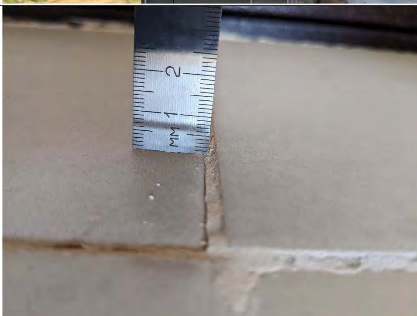
Фото №21. Уступы керамических плиток составляет 3 мм в коридоре.
