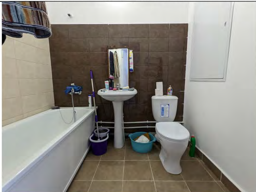
Фото №1. Общий вид санузла в квартире.
