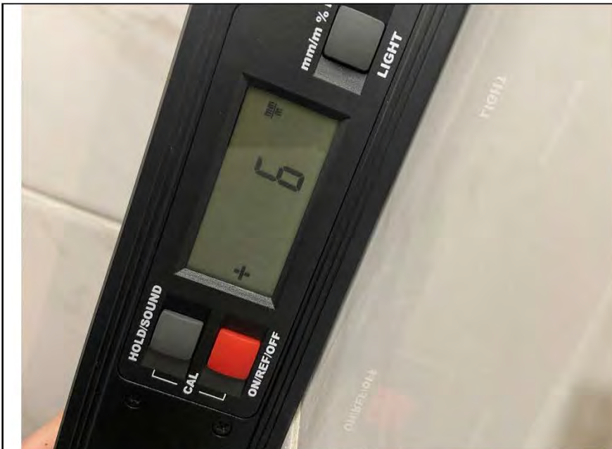
Фото №13. Измерение уровня стен в санузле.
