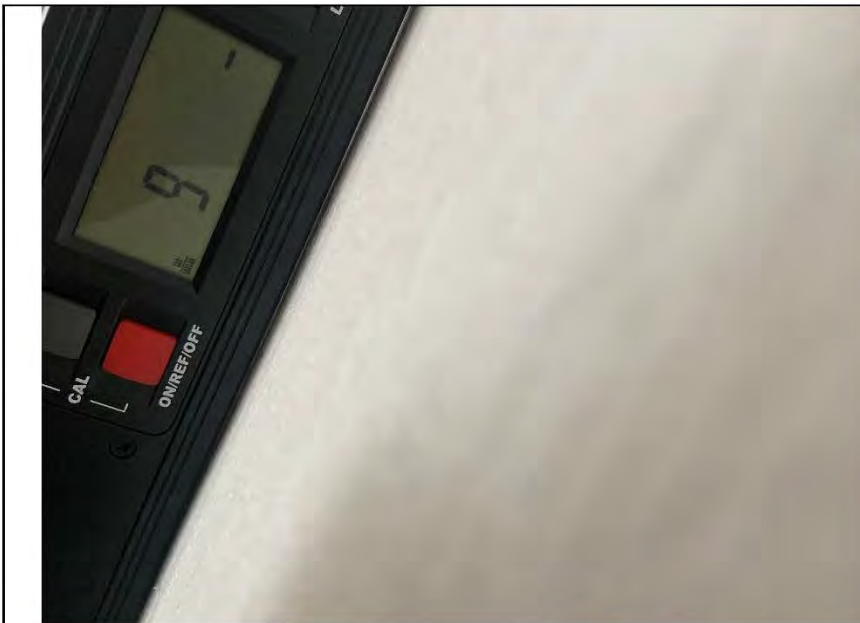
Фото №10. Измерение уровня стен в кухне.
