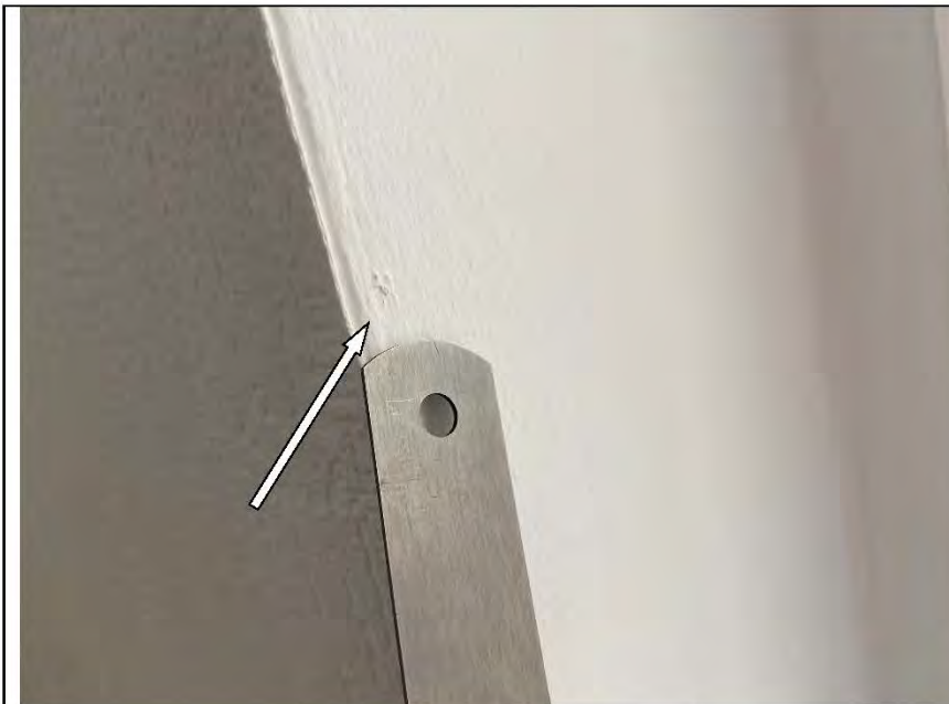
Фото №67. Неровности, сколы, выбоины на окрашенных откосах оконного блока ПВХ в кухне.
