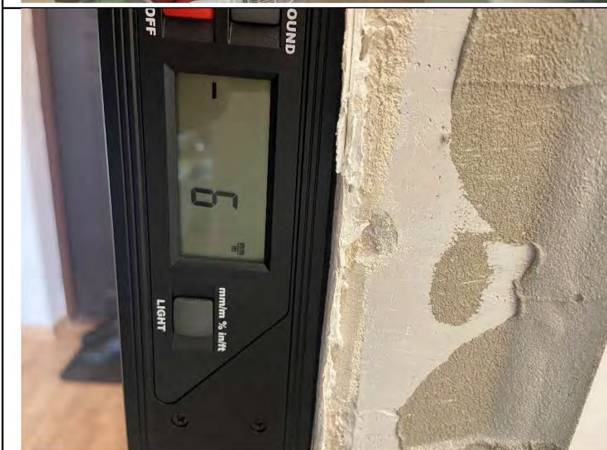
Фото №9. Измерение уровня стен в коридоре.
