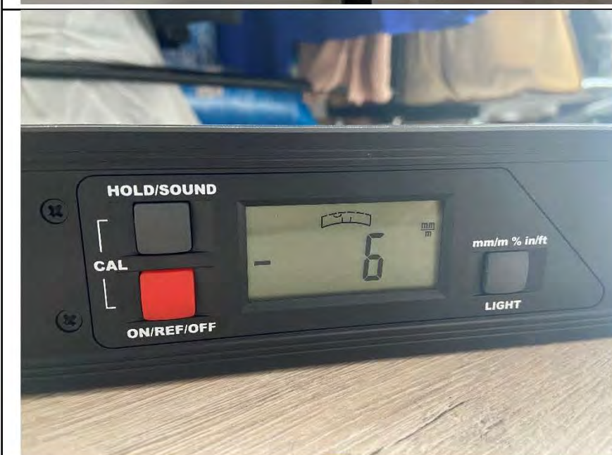
Фото №21. Отклонение напольного покрытия из ламината в кабинете.
