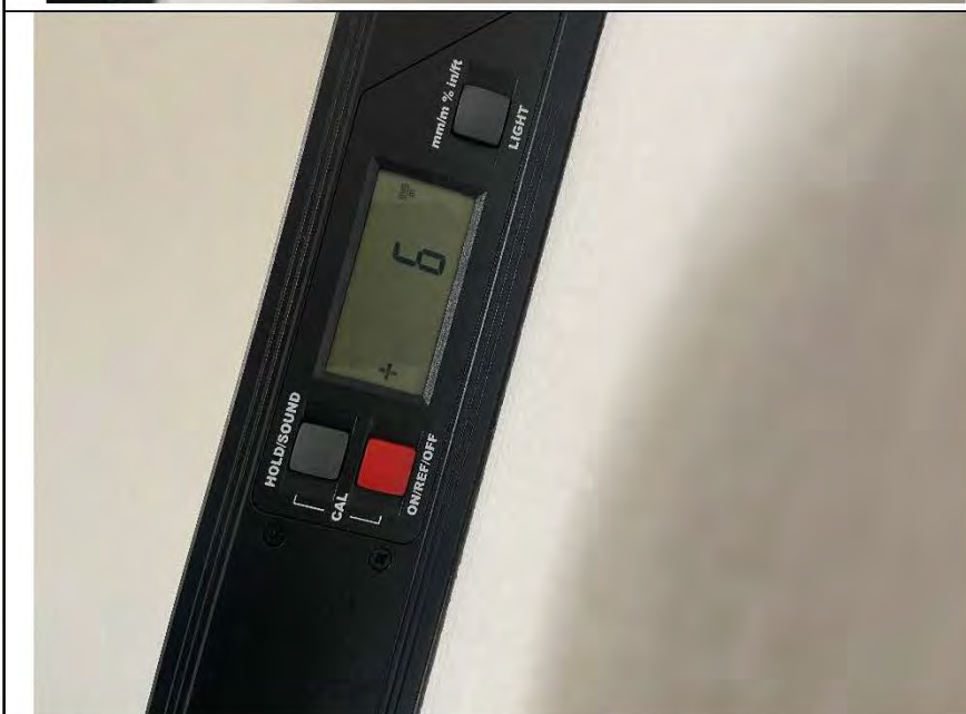
Фото №11. Измерение уровня стен в кабинете.
