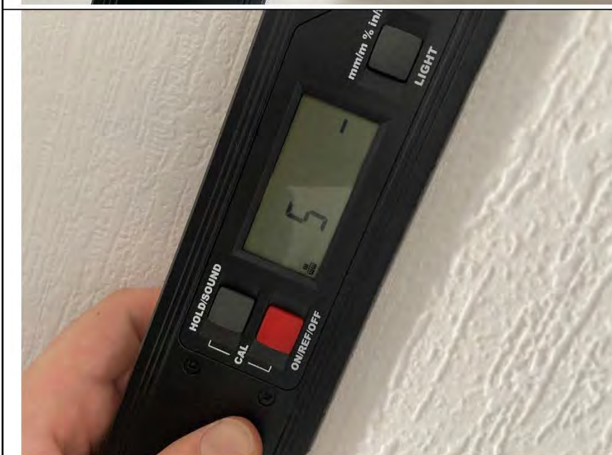
Фото №12. Измерение уровня стен в спальне.
