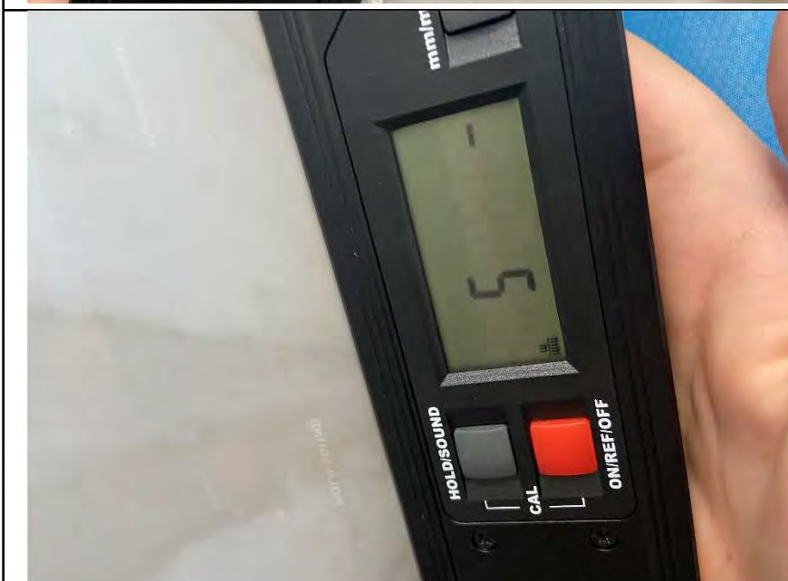
Фото №14. Измерение уровня стен в ванной комнате.
