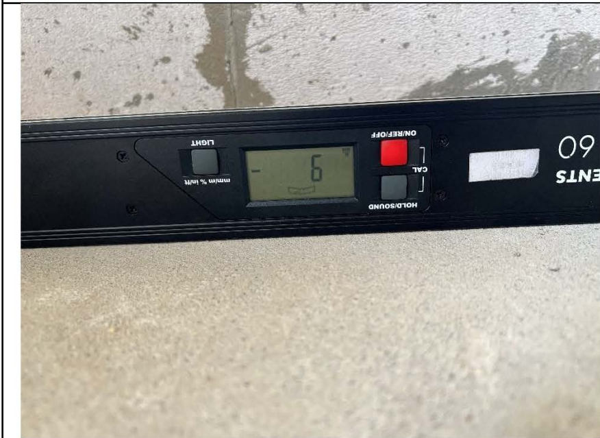
Фото №15. Измерение уровня стяжки в кухне.
