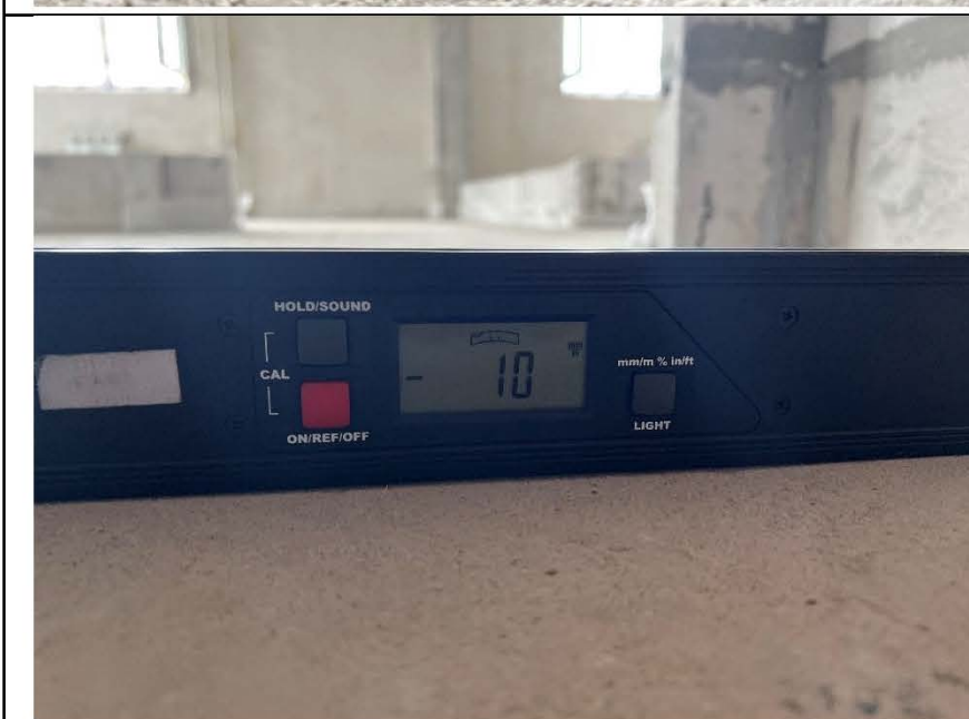
Фото №12. Измерение уровня стяжки в санузле.
