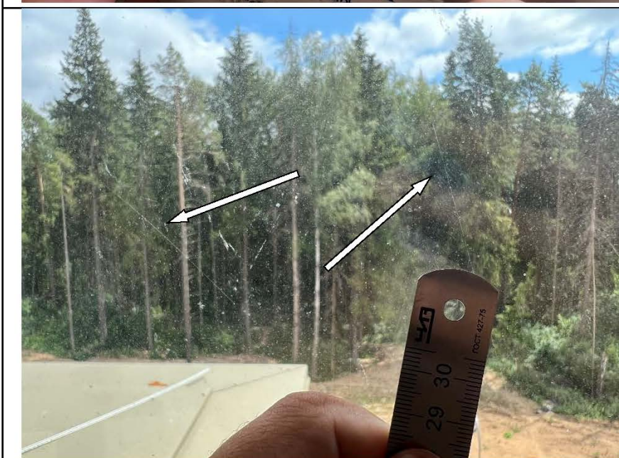
Фото №29. Царапина на стеклопакете оконного блока ПВХ в спальне.
