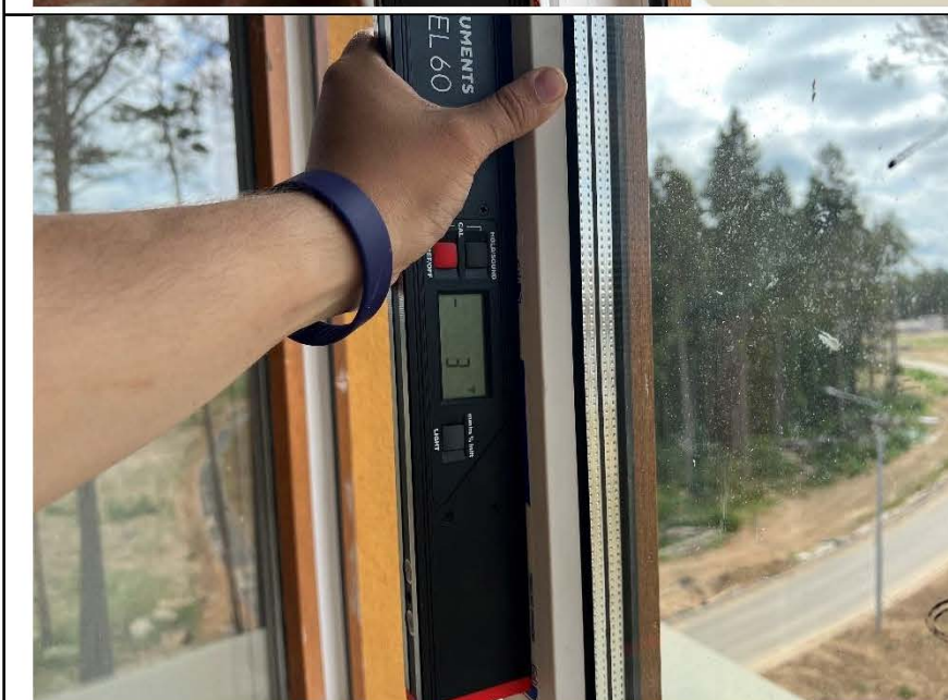
Фото №42. Отклонение оконного блока ПВХ в гостиной по уровню вертикальности составляет 3 мм.
