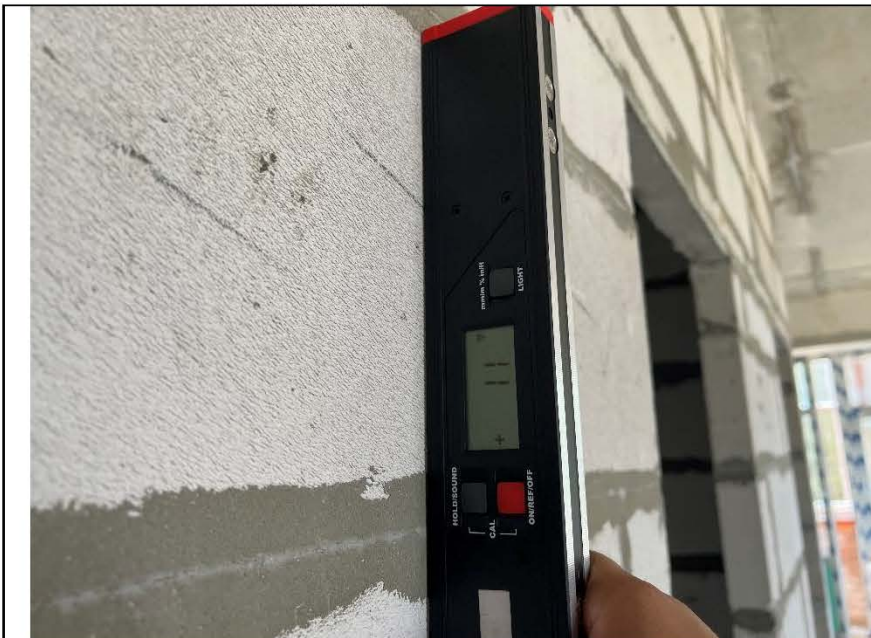
Фото №19. Измерение уровня стен в коридоре.
