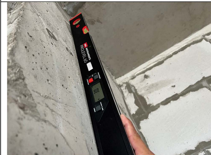
Фото №23. Измерение уровня пиллона в коридоре.
