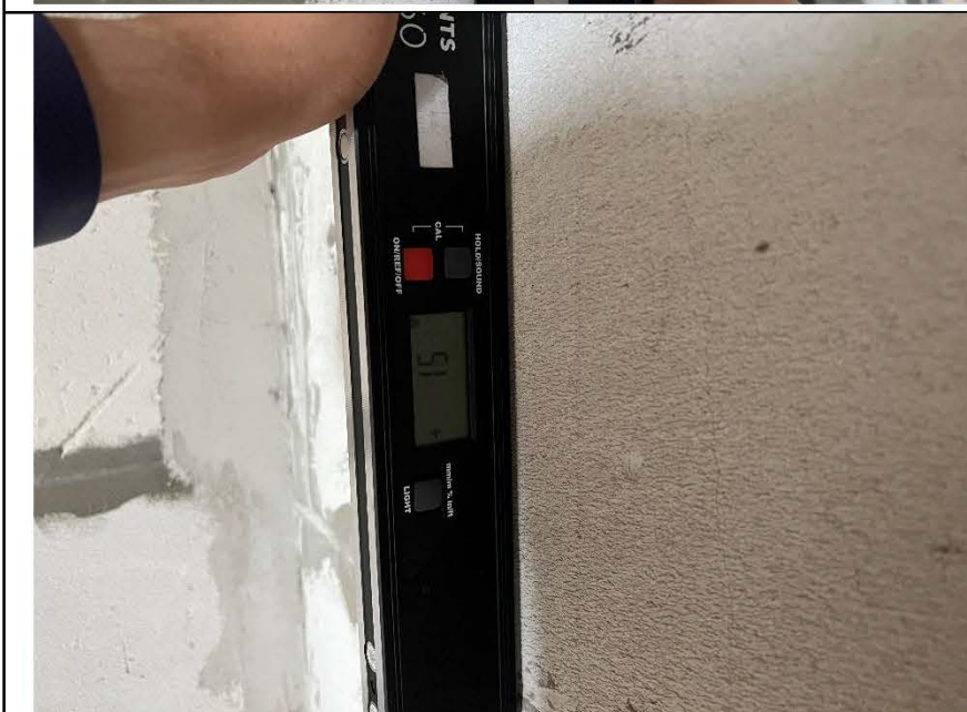
Фото №20. Измерение уровня стен в ванной комнате.
