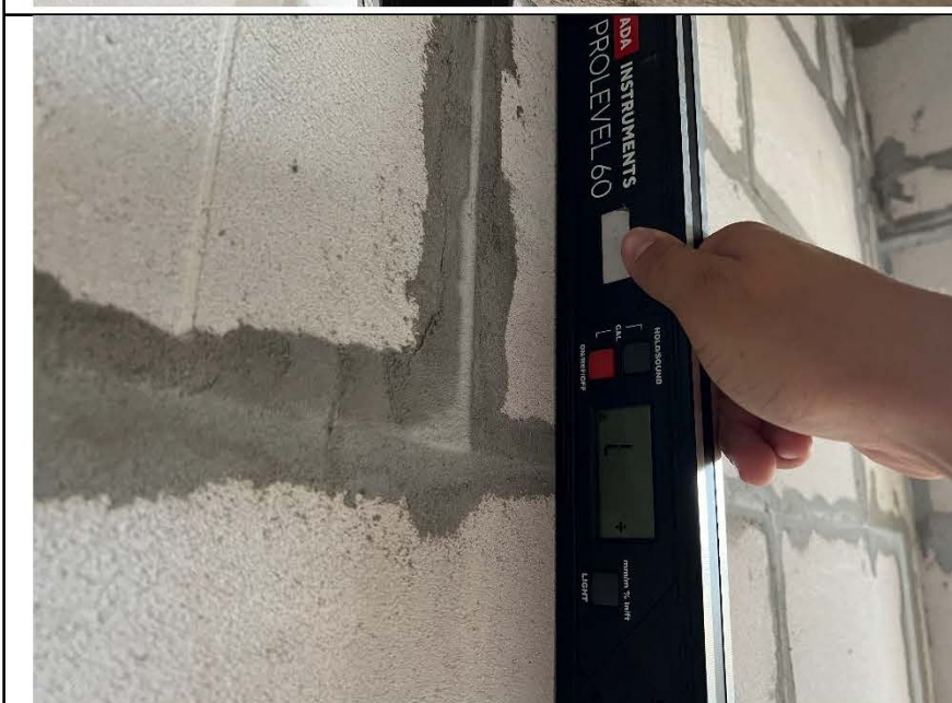
Фото №21. Измерение уровня стен в санузле.
