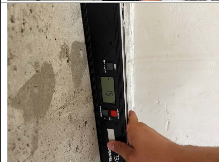
Фото №24. Измерение уровня пиллона в кухне.
