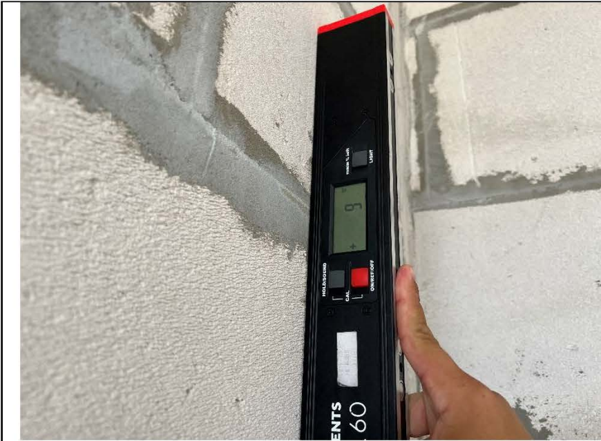
Фото №22. Измерение уровня стен в кухне.
